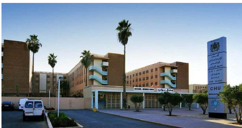
Figure 60 : Photo extérieure du CHU MOHAMMED VI
