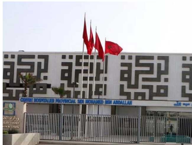
Figure 52 : Centre hospitalier provincial d'Essaouira
