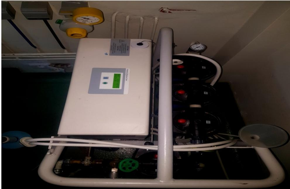
**Figure7 : Station de traitement d'eau pour hémodialyse**
